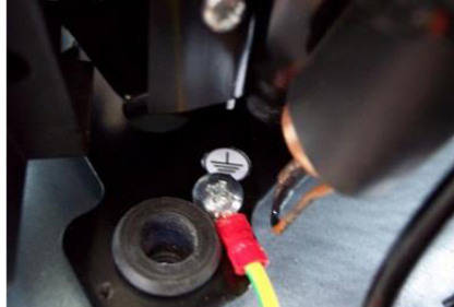
Figure 12 : Connexion particulière câble de terre sur la partie métallique du compresseur
