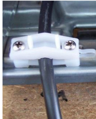
Afbeelding 13: Detail dubbele bevestiging van de kabel
